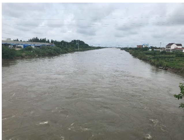
九圩港-如泰运河清水通道维护区
