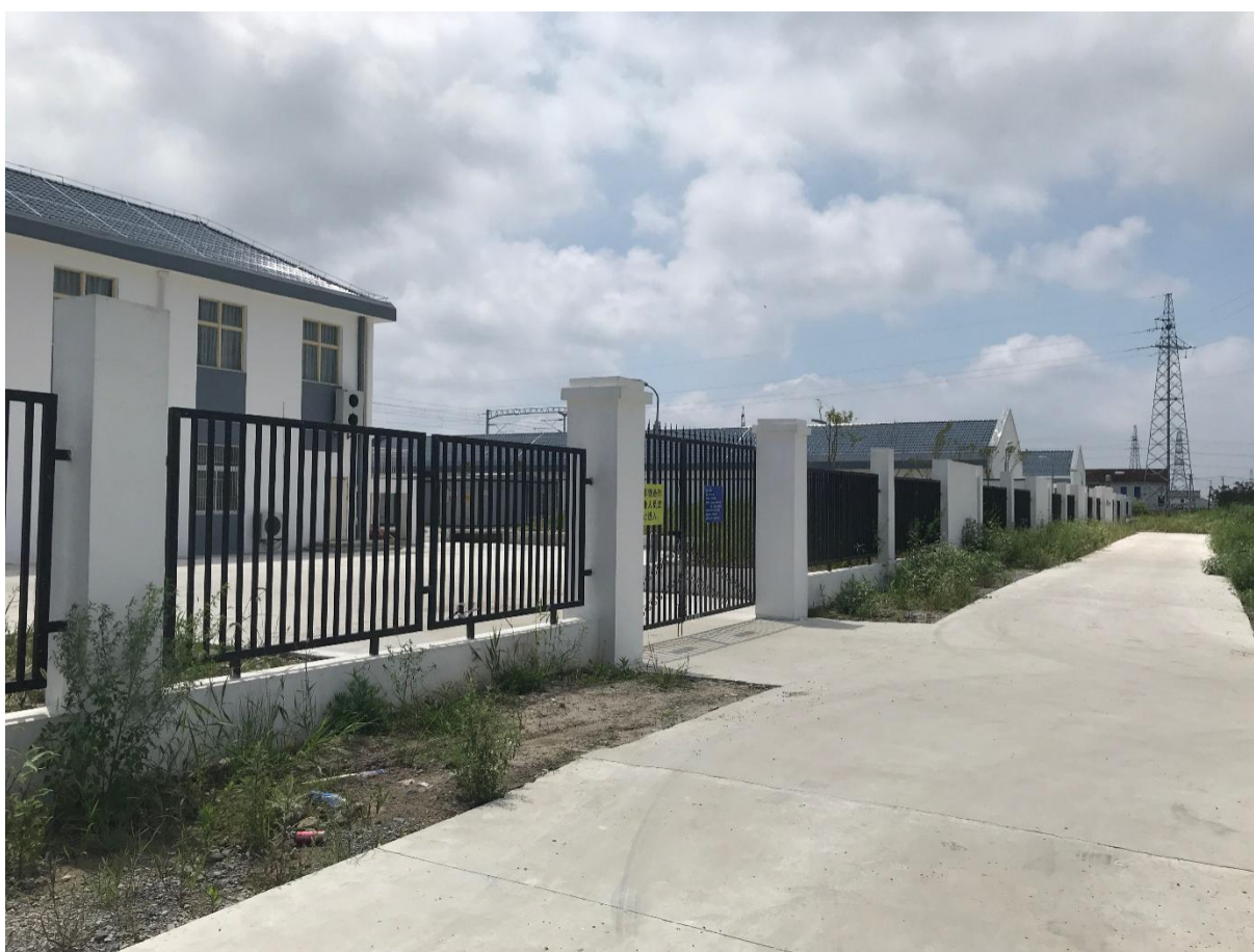
图 2.1-2 吕四港站现状照片
